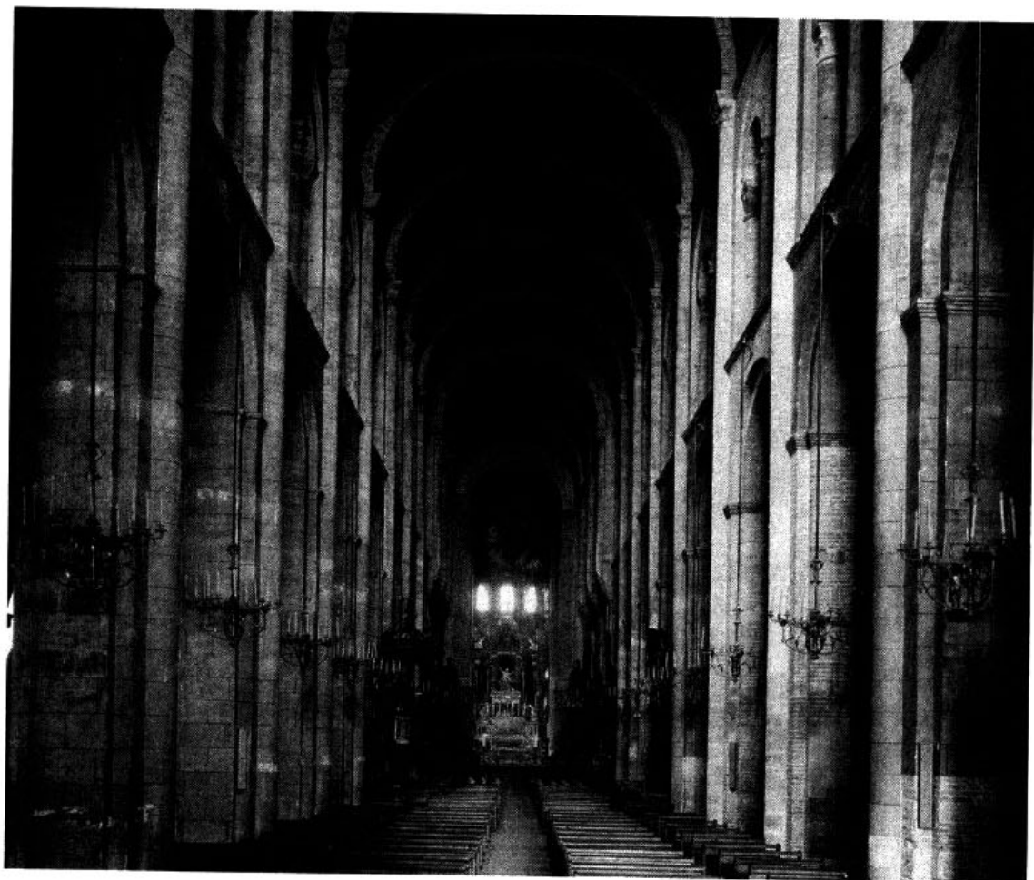
图 12.3 罗马式建筑:内部 图卢兹的圣塞宁教堂(The Church of St. Sernin)建于 1100 年前后数十年。这张照片是它的中心,在人工灯光下拍摄,它说明了石拱顶是需要大墙来支撑的,并对这种建筑内部的阴暗作了展示。
