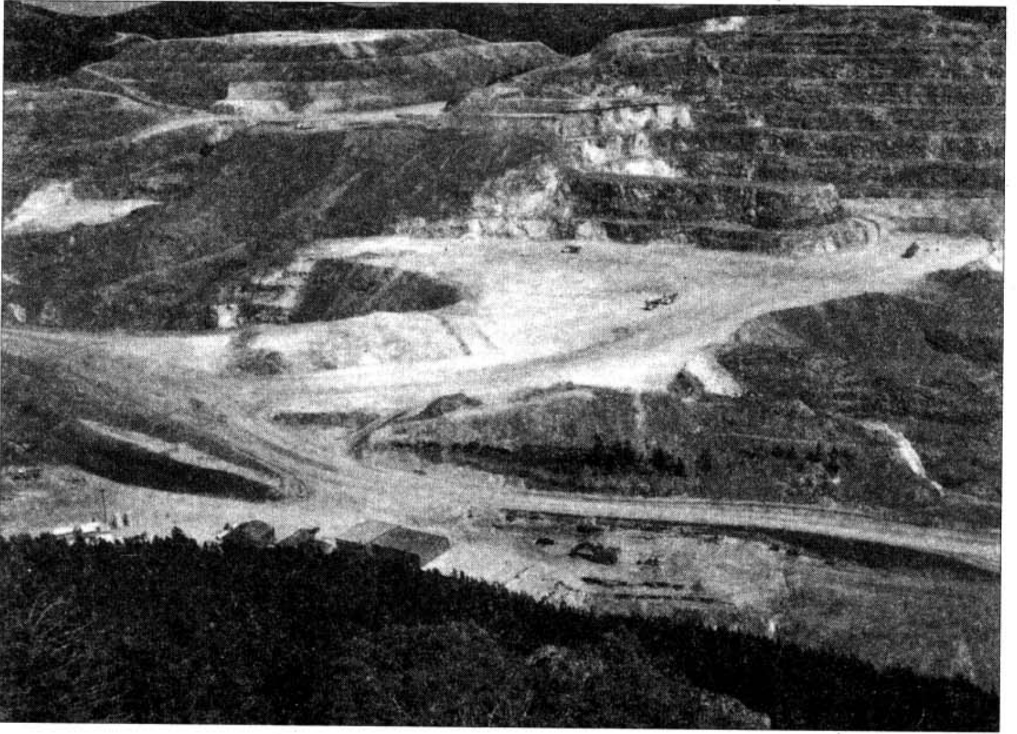
图 4 蒙大拿州已废弃的佐特曼·兰达斯基矿场, 曾是美国第一个大规模利用氰化物堆浸提取微量黄金的矿场。
