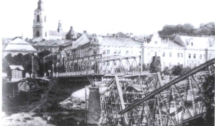
■ 撤退中的俄軍努力摧毀沿途一切交通設施以阻礙德國的推進，圖為華沙近郊一座被炸毀的鐵橋。
