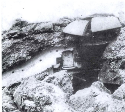
■ 這堆不知所謂的殘骸曾經是列日要塞的一部分，中間那道白色色是要塞中的一道走廊，頂部分成兩塊的碎片曾是這座堡壘的頂蓋。一枚420mm的重型砲彈為世人上了一堂生動的「要塞解剖學」課程。
