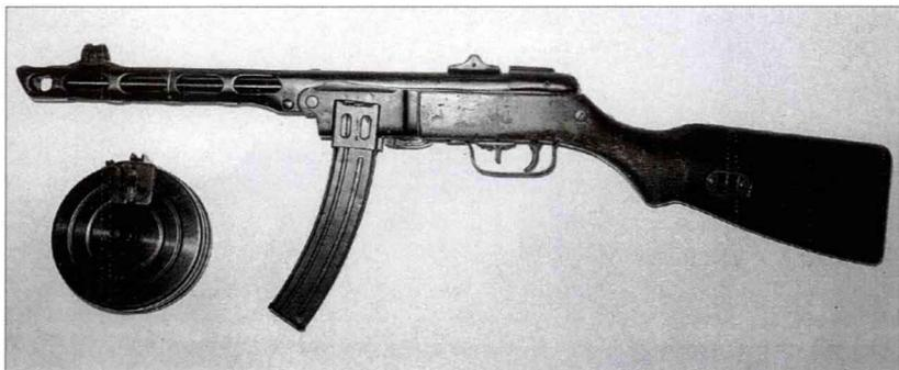
前苏联在二战期间生产的第三款冲锋枪，也是最常见的一种，大约生产了500万支。1947年后，被广泛传播到前苏联等许多东方阵营国家，世界各地都有其身影。虽然生产了可发射9×19毫米巴拉贝鲁姆手枪弹的改进型，但并不常见。该枪取代了PPS-40，可使用弹匣或弹鼓，生产起来更简单、快捷。早期型号有可调节的弧形照门，后来的型号大多数采用简单的翻转式两档照门。
